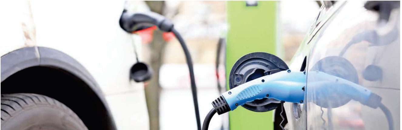
Der Ausbau von Ladestationen im öffentlichen Raum ist zwingend.
